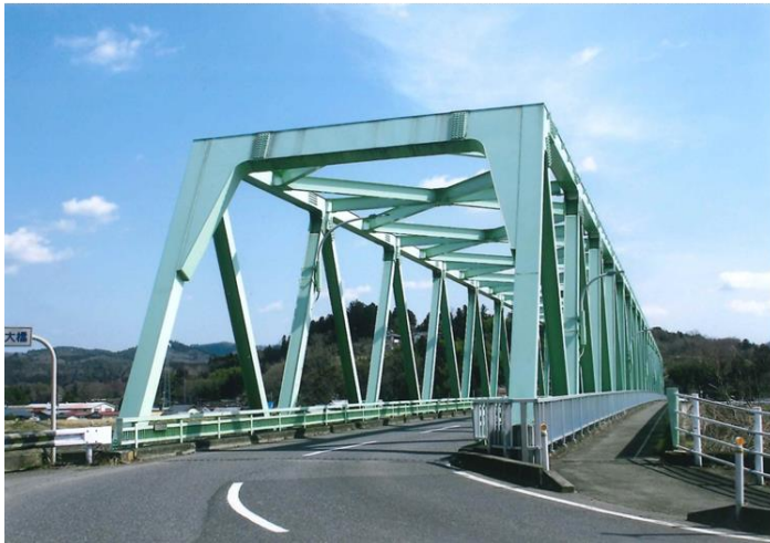
現在の米谷大橋
