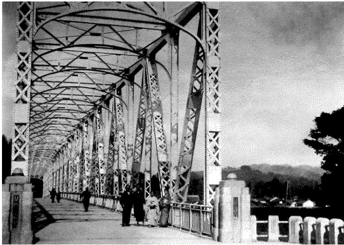
昭和5年7月 米谷大橋及び 取付け道路竣工。
